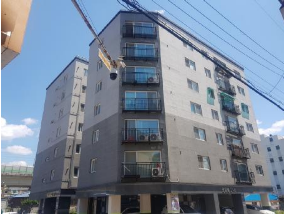
본건 전경(북서측에서 촬영)
